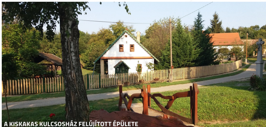
A KISKAKAS KULCSOSHÁZ FELÚJÍTOTT ÉPÜLETE
