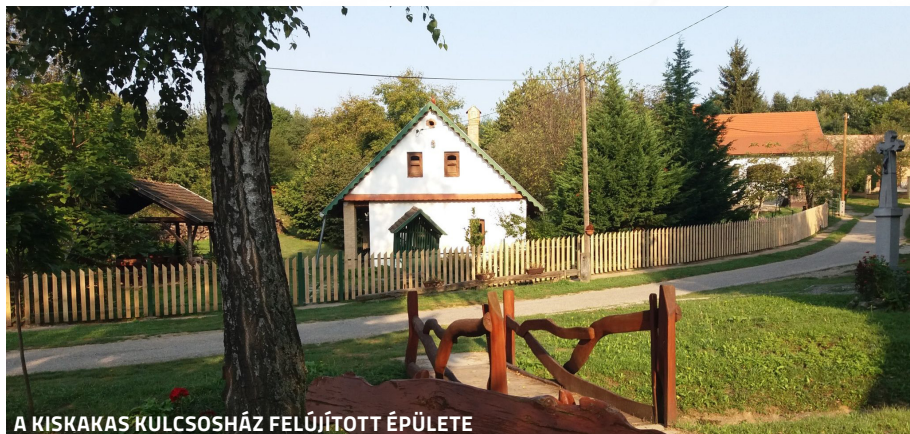
A KISKAKAS KULCSOSHÁZ FELÚJÍTOTT ÉPÜLETE
